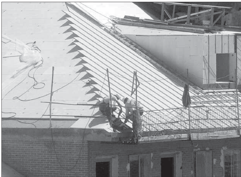
Las inundaciones se han producido a causa de los cambios de la cubierta del Hospital General
