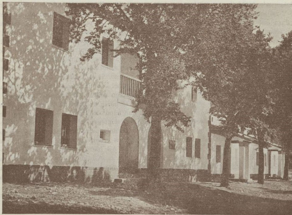
Uno de los bloques de Viviendas Protegidas, del Barrio de San Andrés, en construcción.
