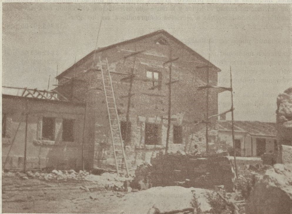
Centro Primario de Higiene Rural y Casa del Médico, en construcción
