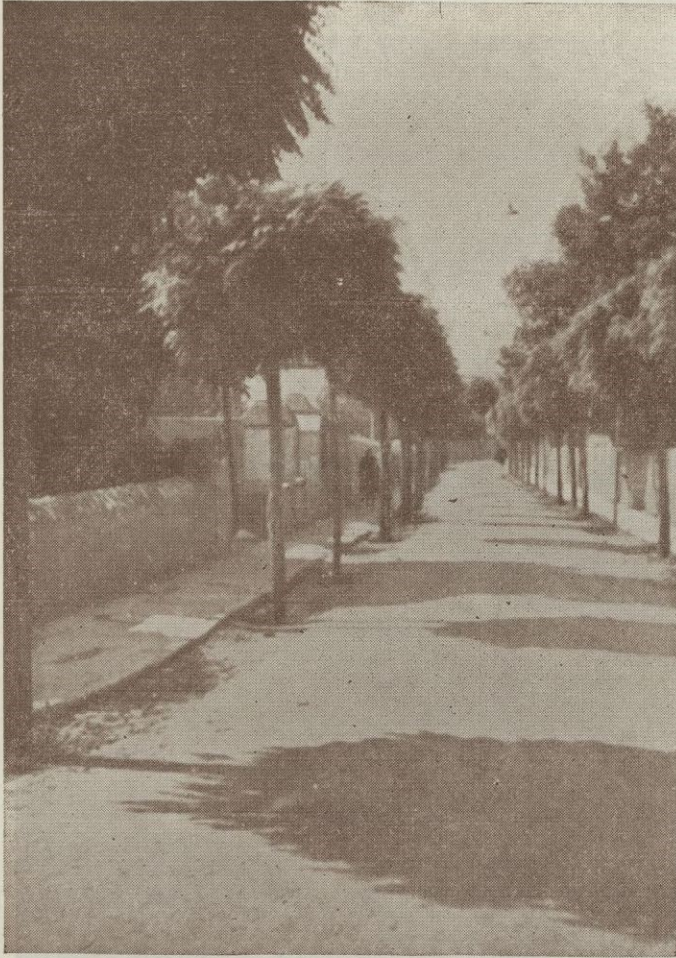
Calle José Antonio, con su nuevo pavimento
