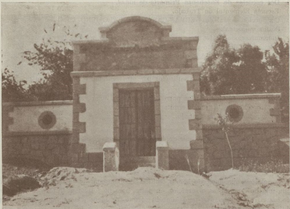
Nuevo depósito regulador del servicio de abastecimiento de agua, en construcción
