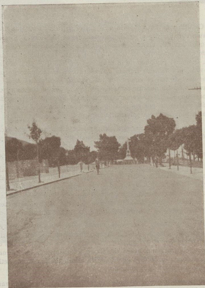
Calle de Gabriel y Galán, con su nuevo pavimento
