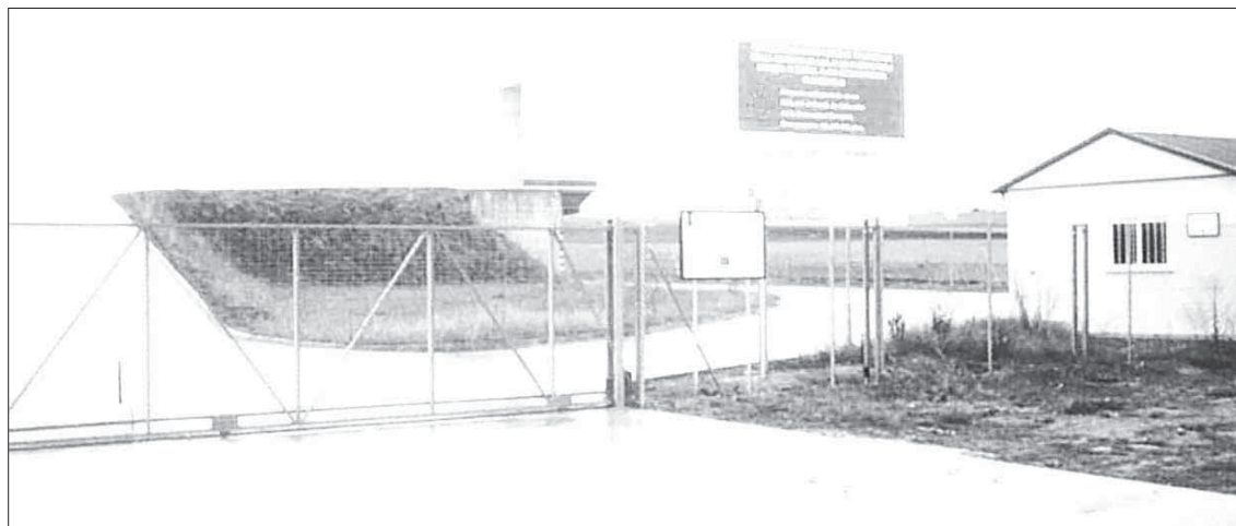
Los subproductos no reutilizables son tratados y depositados en un depósito controlado de rechazos
