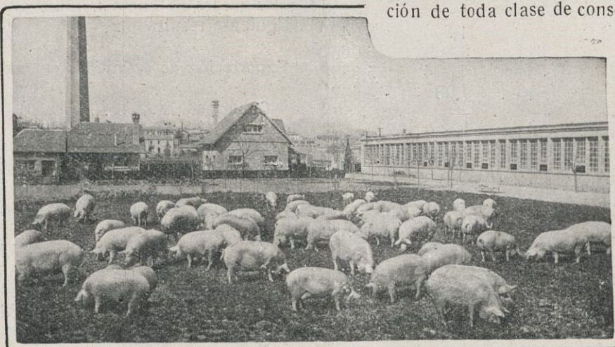
Una vista parcial de la fábrica
