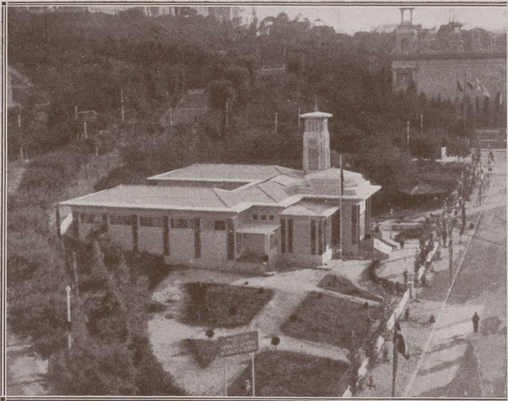
Vista exterior del Pabellón de la Compañía General de Tabacos de Filipinas en la Exposición Internacional de Barcelona, situado en la Avenida del Príncipe, entre los Palacios de Alfonso XIII y el de la Agricultura
