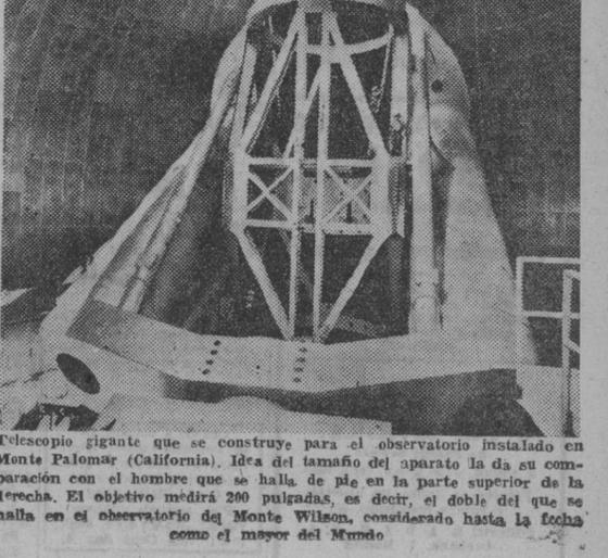
Telescopio gigante que se construye para el observatorio instalado en Monte Palomar (California). Idea del famoso del aparato de su comparación con el hombre que se halla de pie en la parte superior de la derecha. El objetivo medirá 200 pulgadas, es decir, el doble del que se halla en el observatorio de Monte Wilson, considerado hasta la fecha como el mayor del mundo.
