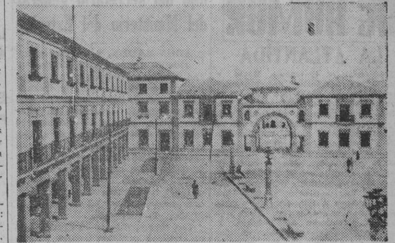
Viviendas construidas por la Dirección de Regiones Devastadas, en Andújar (Jaén)
