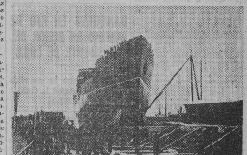
Momento de ser lanzado al agua el nuevo petrolero español «Bailén», construido en la factoría naval de Matagorda. Desplaza 16.205 toneladas y puede cargar 10.000 toneladas de combustible. (Foto Cifra)
