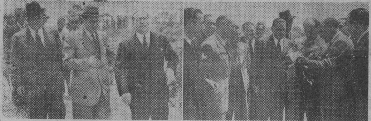
El señor Ibáñez Martín, acompañado del gobernador civil y del rector de la Universidad, ha verificado una visita a los terrenos de la futura Residencia de Estudiantes, escuchando las explicaciones de los arquitectos sobre el mismo terreno. (Fotos P. de Rozas)
