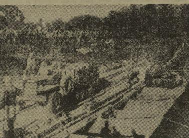
Vehículos norteamericanos, pertenecientes a las fuerzas que luchan en Filipinas, cruzando un puente tendido sobre un río de la isla de Leyte por el Cuerpo de Ingeni ros que acompaña a las fuerzas expedicionarias. Este puente fué construído en cuatro horas en substitución de otro volado por los japoneses en su retirada. — (Foto recibida por radio)
