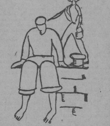
Los trabajos en ejecución en la zona y puerto franco de Barcelona.
