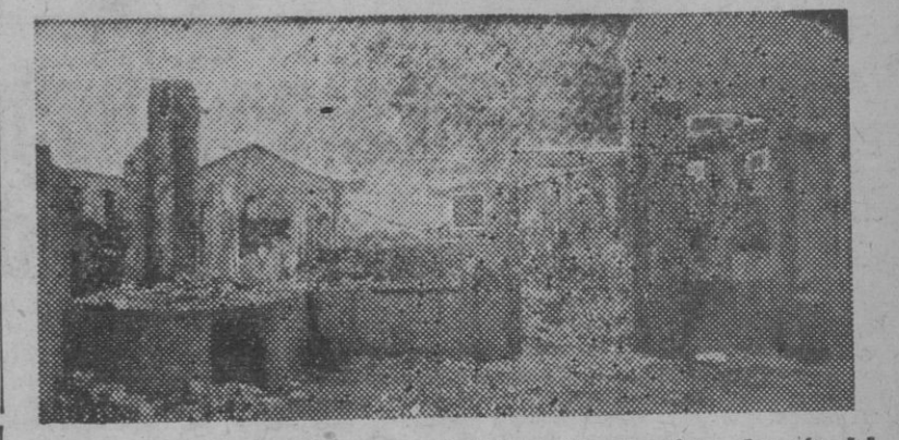
Fábrica de hilados y tejidos de Manuel Gorina Ramírez, después del incendio efectuado por los rojos, en Sabadell
