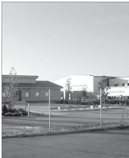
Instalaciones de Aserraderos de Cuéllar
