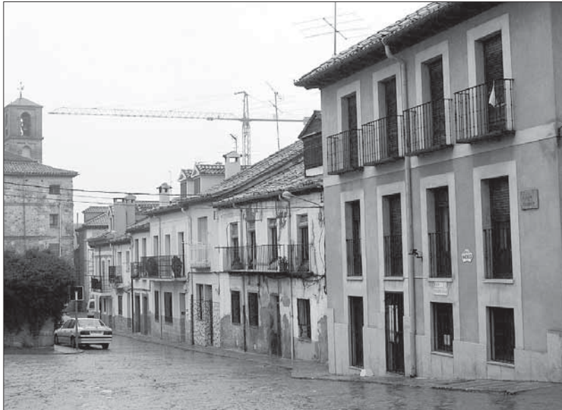
El plan prevé el embellecimiento de las calles con el soterramiento del tendido eléctrico
