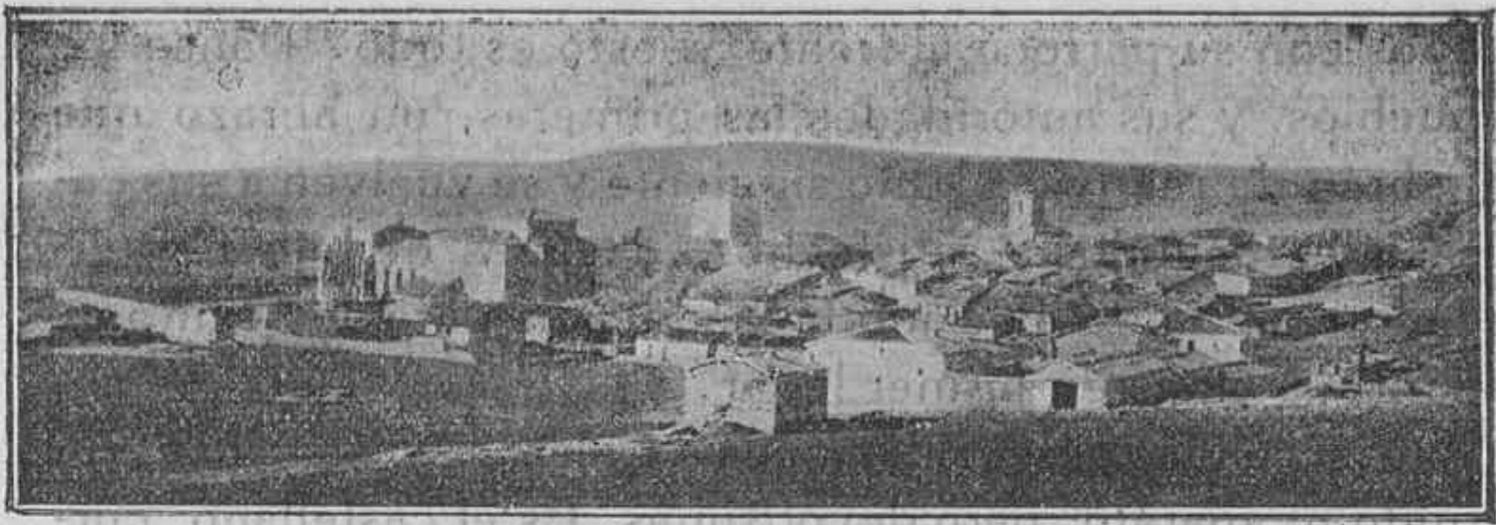
VISTA GENERAL DE CALERUEGA
