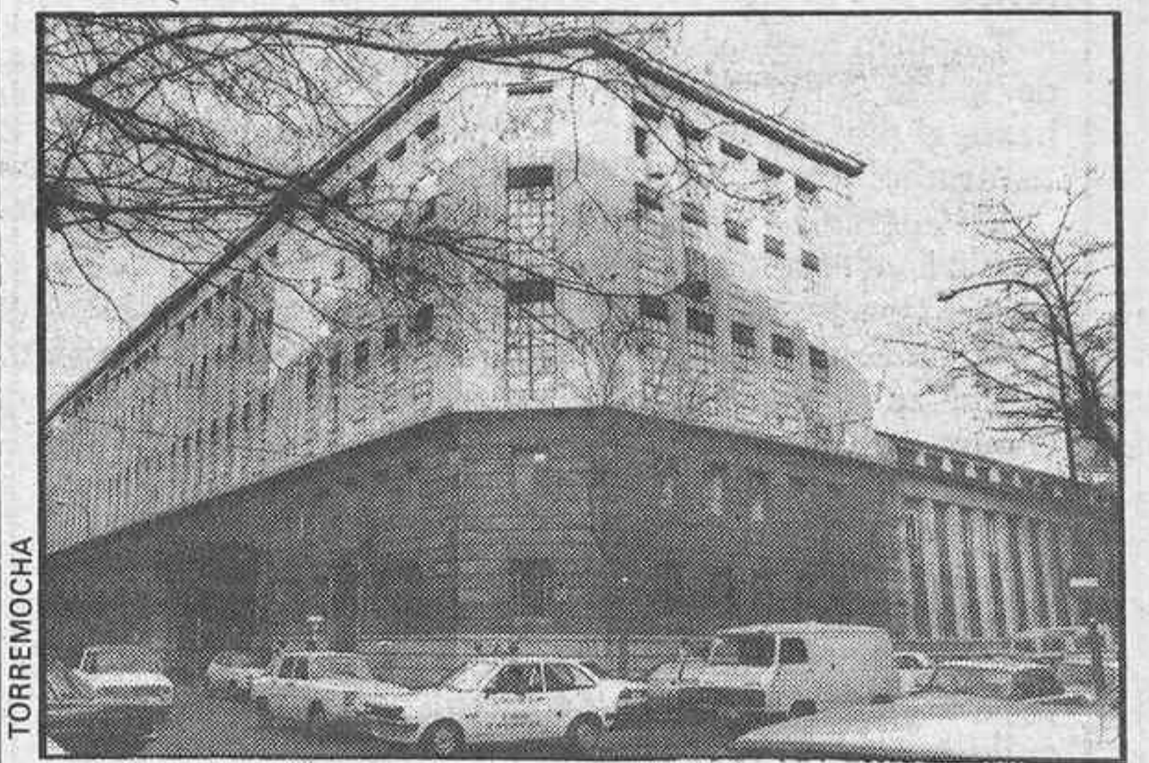
El espacioso edificio de la EMT en la calle de Alcántara albergará numerosas instalaciones deportivas
