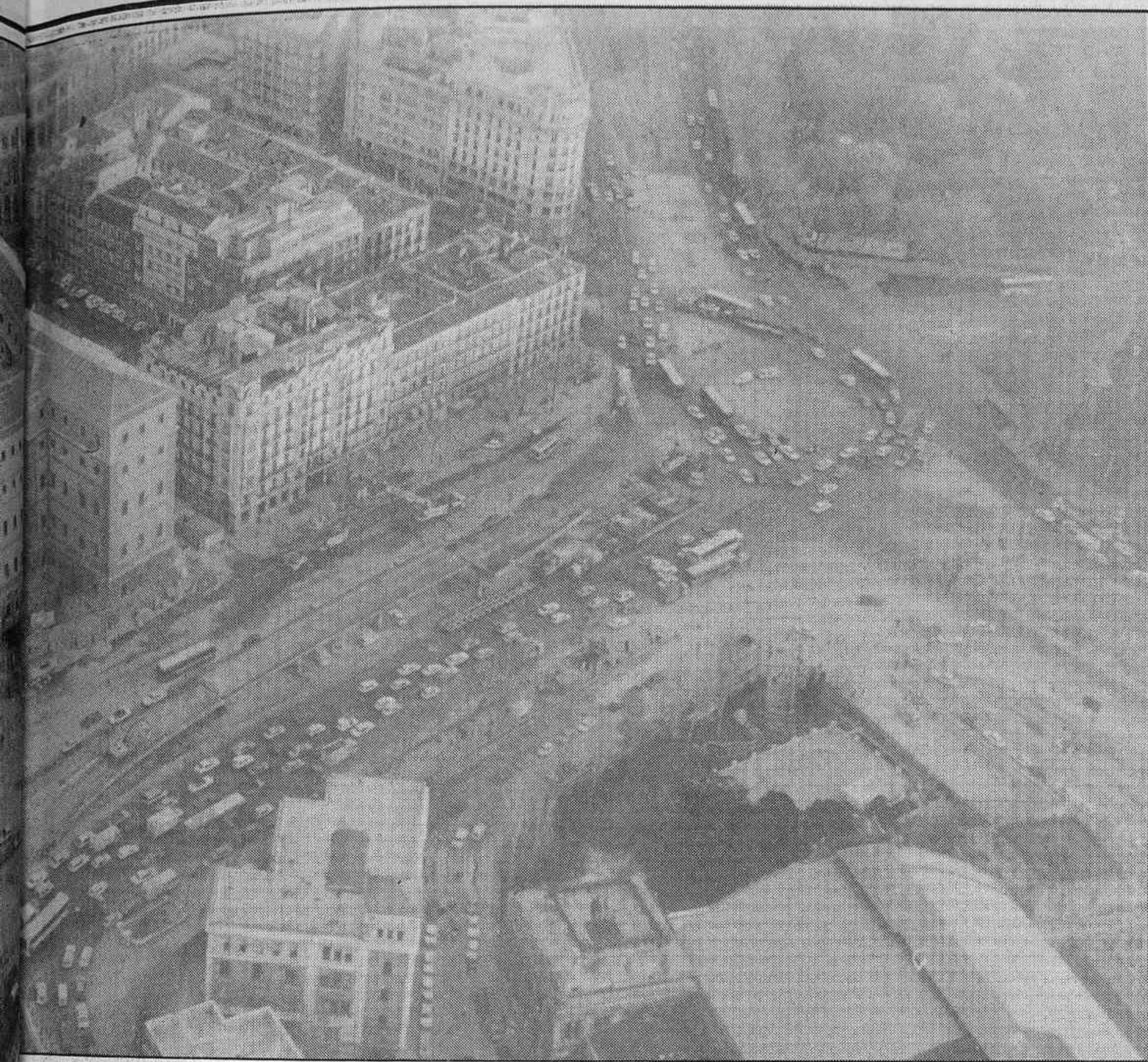
El desmantelamiento del «scalextric» y la reordenación de la plaza de Atocha, una de las obras que con más expectación está siguiendo el ciudadano madrileño.
