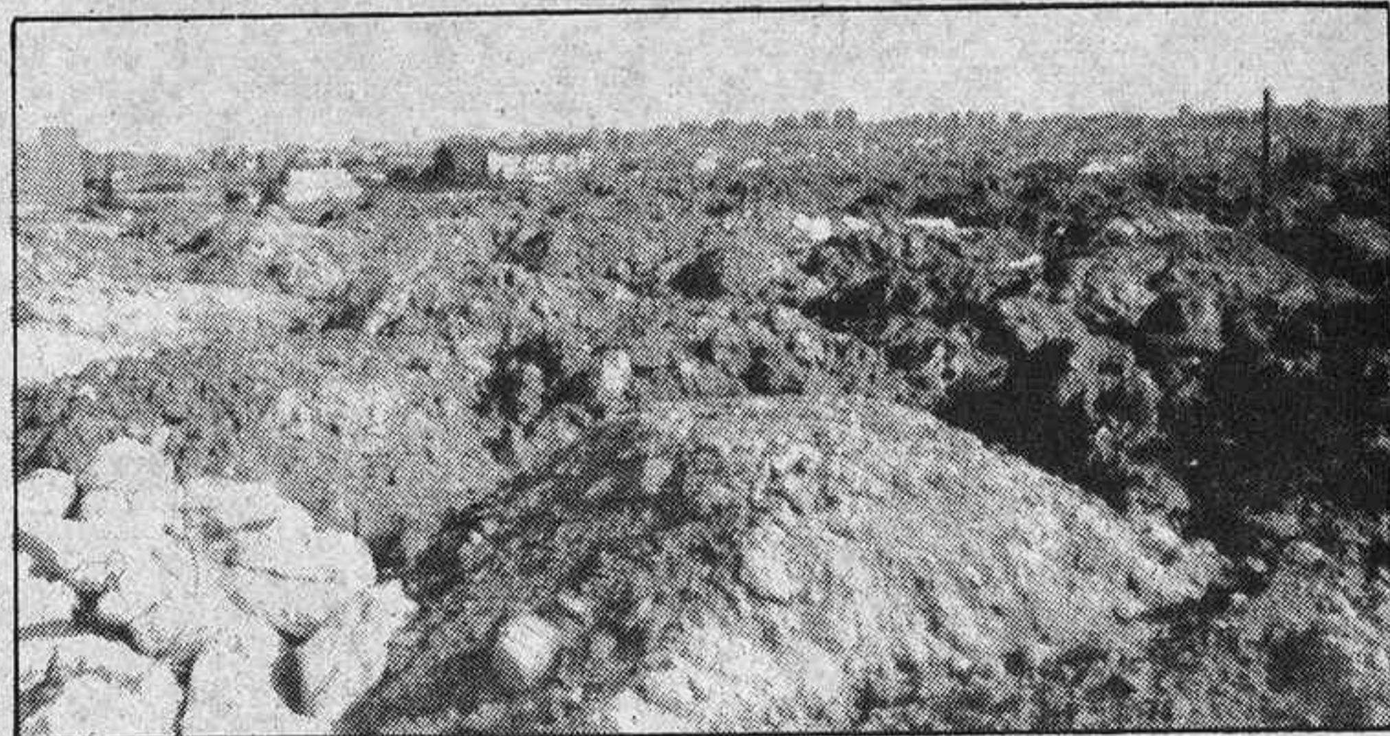
Sobre estas escombreras se realizará el Parque de Delicias, con especies arbóreas seleccionadas.
