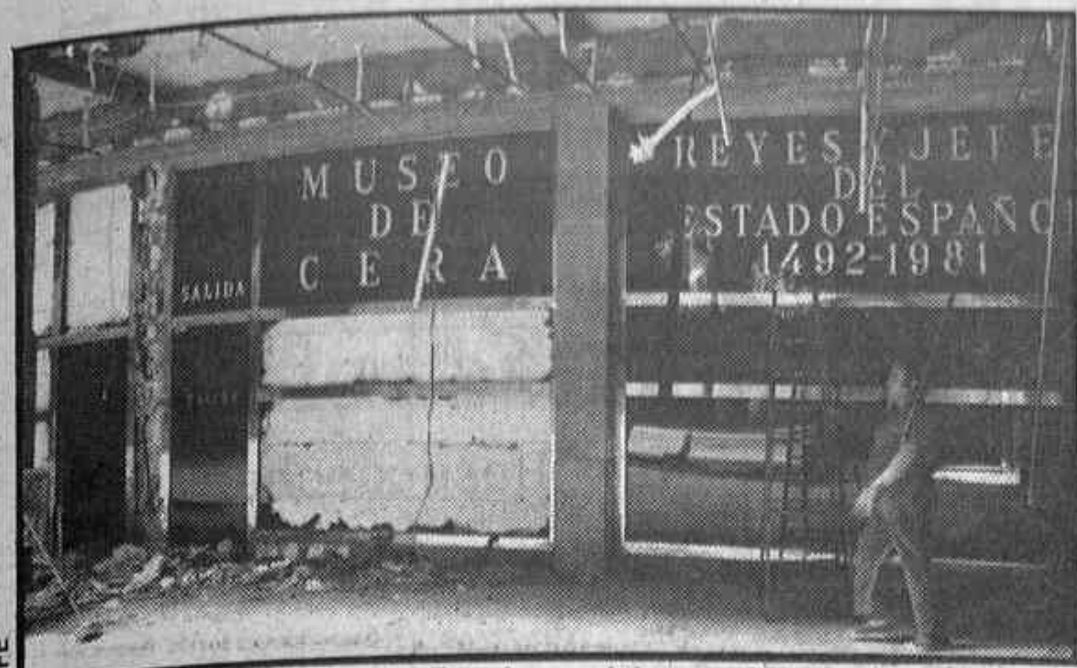
La sala de reyes y jefes de Estado resultó muy dañada a causa de la explosión del artefacto
