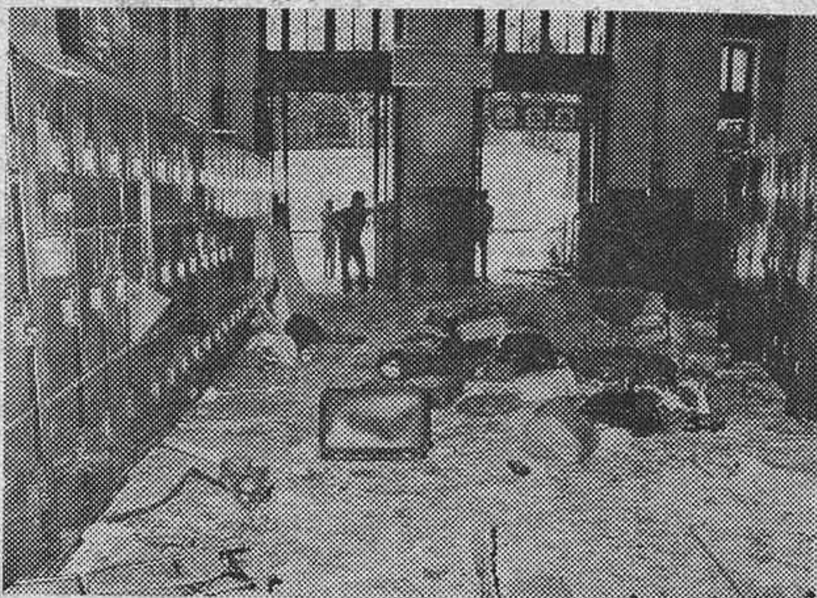
Este es el desolado aspecto que ofrecía ayer la consigna de la estación de Atocha, en uno de cuyos armarios fue colocada la bomba.
