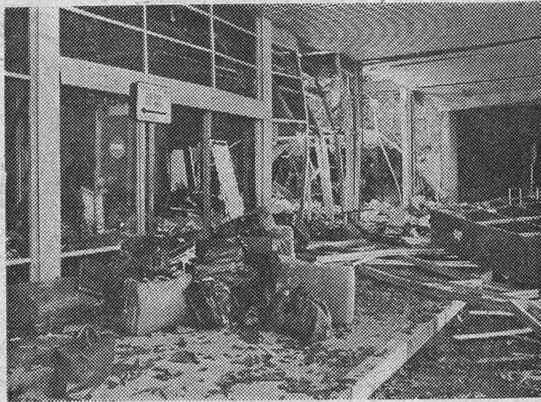
Así, completamente destrozada, quedó la consigna nacional del aeropuerto de Barajas
