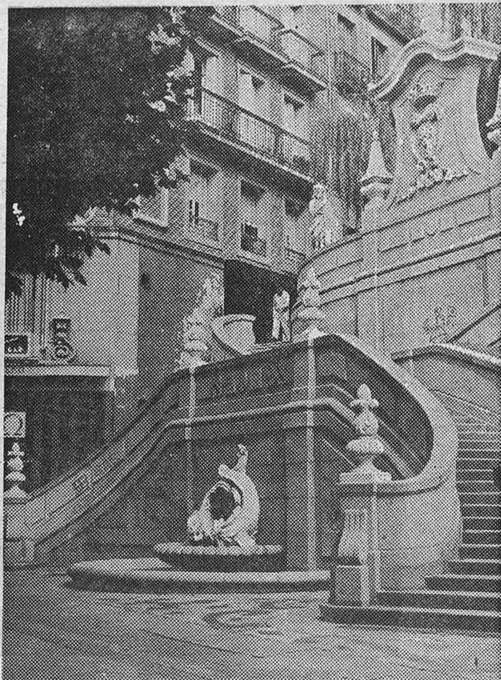
Esta es la fuente-escalera acceso a la plaza de Cristino Martos desde la calle de la Princesa. Siempre seca, en ella se depositan papeles, escombros y zapatos viejos. (J. Gallego.)
