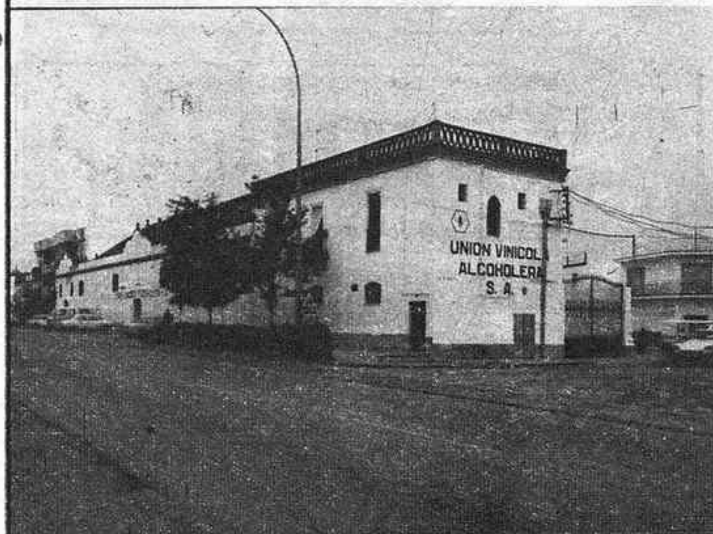
Planta de elaboración de Unión Vinícola Alcohólica en Los Palacios
