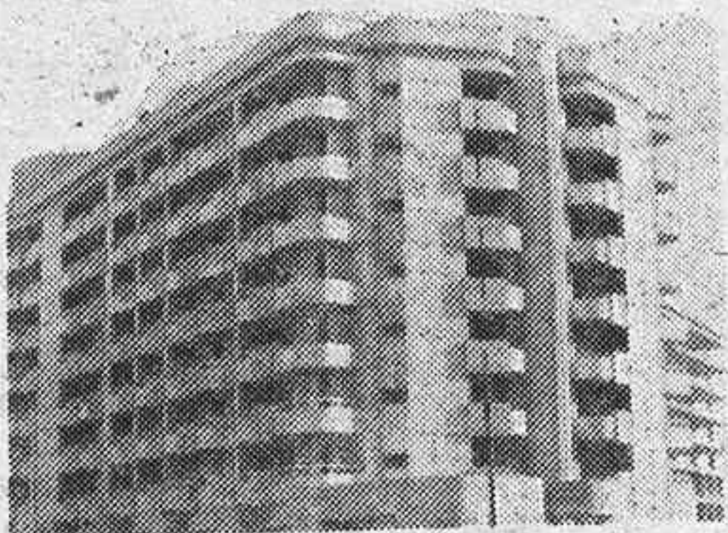
Una perspectiva del complejo residencial Marbell Center (en construcción), en uno de los mejores lugares de la Costa del Sol
