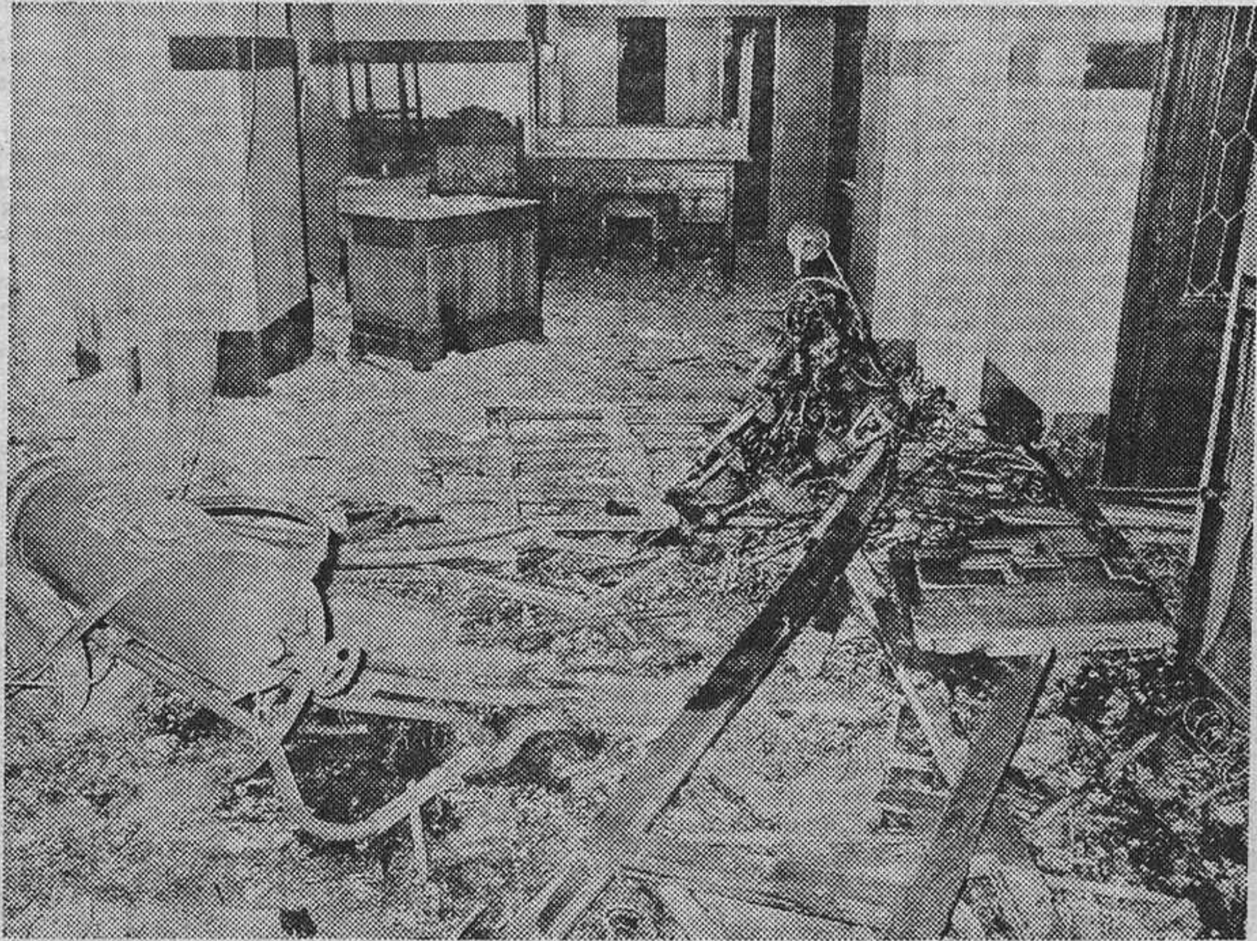
La explosión causó graves daños en el Ministerio de Justicia. (Cifra.)
