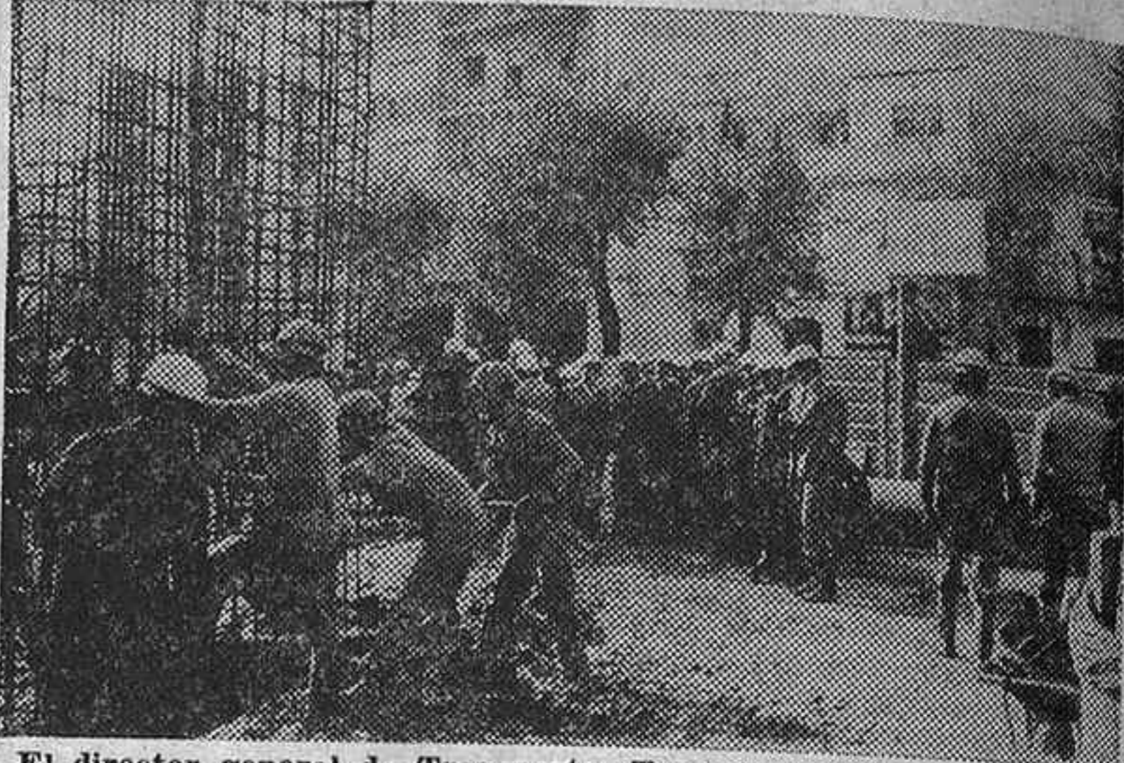
El director general de Transportes Terrestres visita las obras del Metro de Sevilla (Foto Cifra.)
