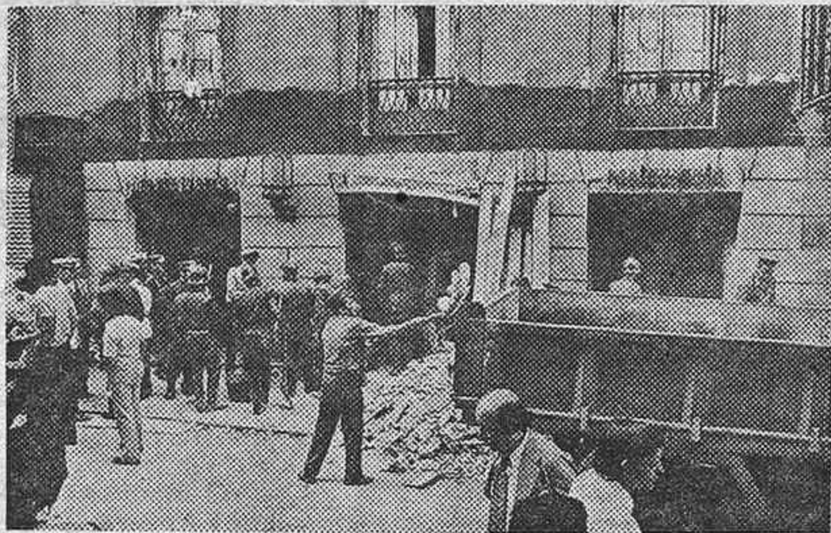
Bomberos y empleados municipales proceden al desescombro
