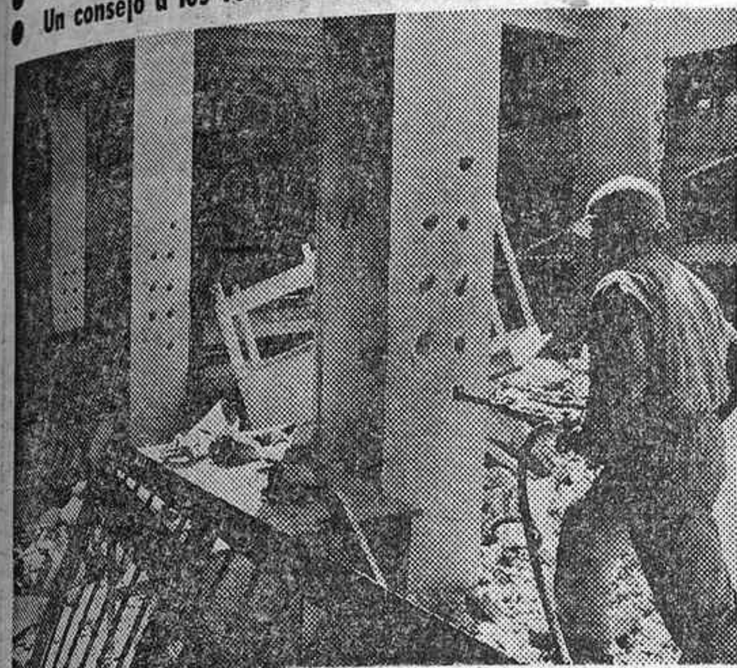
Un trabajador abre con una taladradora especial los barrenos en las vigas que sustentaban la sala de platina del periódico "Madrid". Hay ochocientos taladros de este tipo en todo el edificio. En su interior se alojarán, prensadas, las microcargas de dinamita. (Foto Torremocha.)
