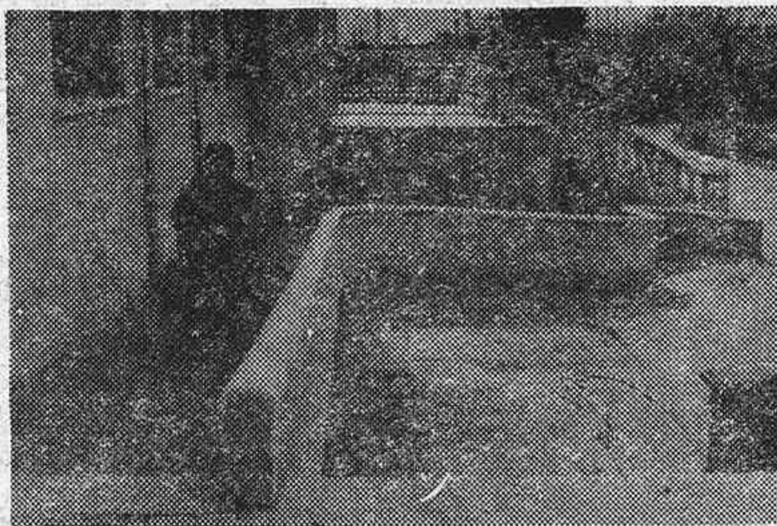
En el Instituto de Rehabilitación de Inválidos, en Carabanchel, radicado en la antigua posesión del marqués de Salamanca, se han construido, a modo de ensayo, con los más positivos resultados para su definitiva adopción, estos accesos fuera de toda barrera arquitectónica...
