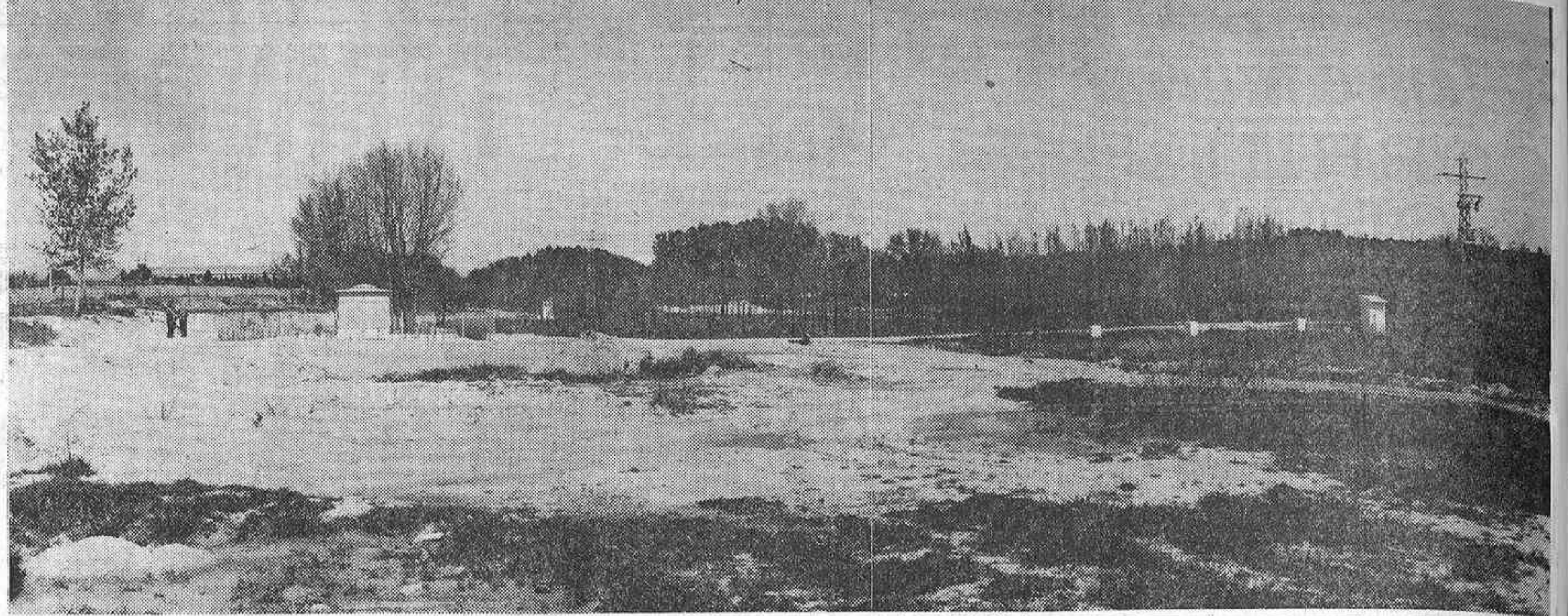
Mañana, en esta gran explanada de los Viveros de la Villa, junto a Puerta de Hierro, se iniciarán los trabajos para la construcción de una gran estación depuradora, que luego verá en el Manzanarés un gran canal de agua limpia. El presupuesto de la estación se cifra en sesenta millones de pesetas y estará terminada antes del verano de 1968. (Foto Torreño.)
