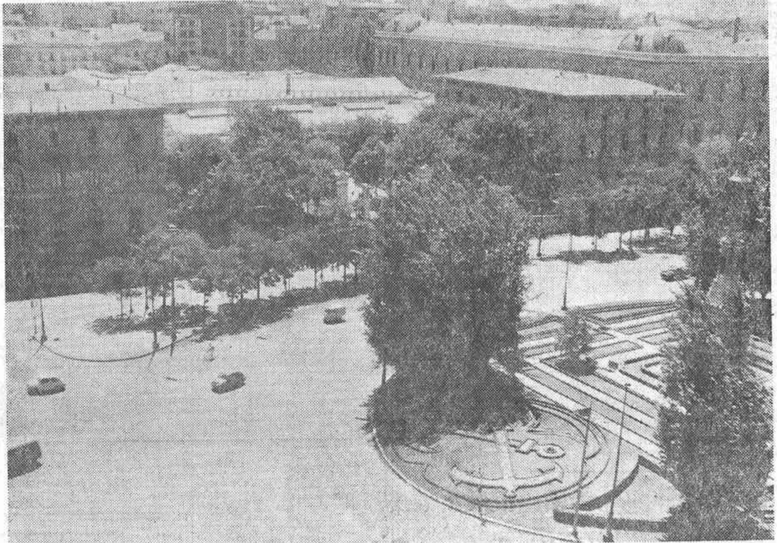
La plaza de Colón se extenderá con el tiempo hasta la calle de Serrano, una vez que sea demolido el edificio de la Casa de la Moneda...
