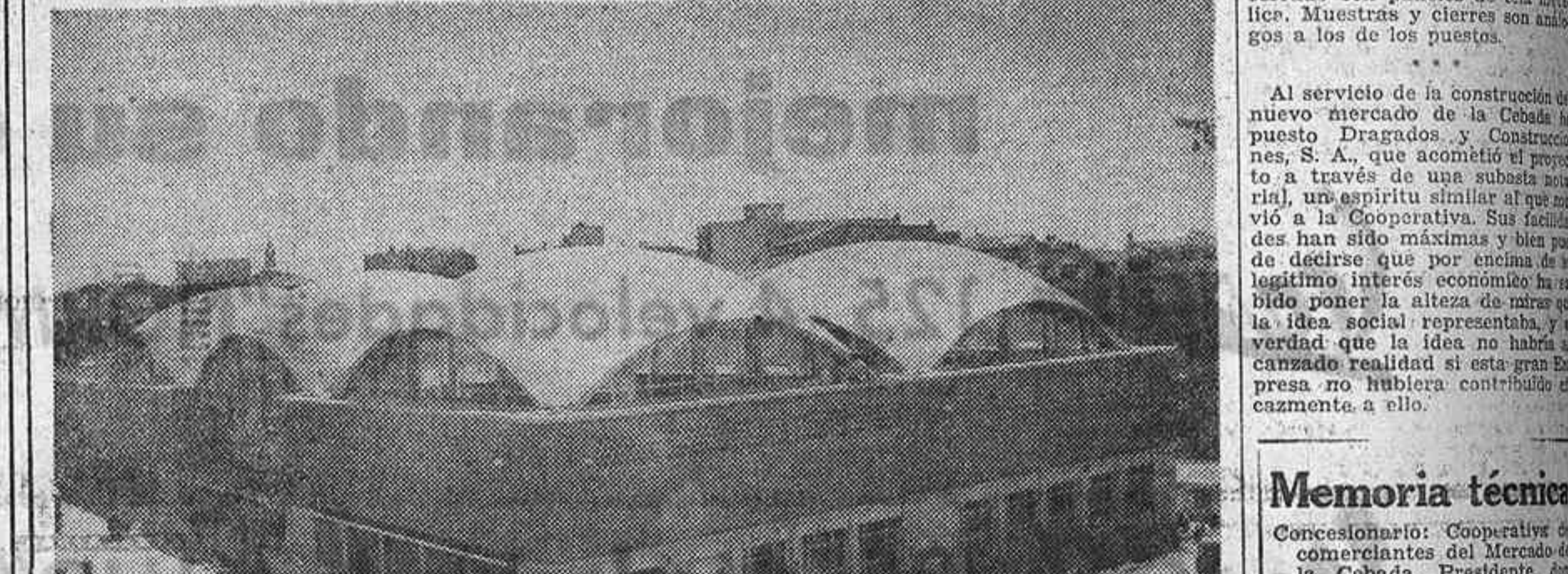
Vista panorámica del modernísimo mercado de la Cebada. (Foto Bariego.)
