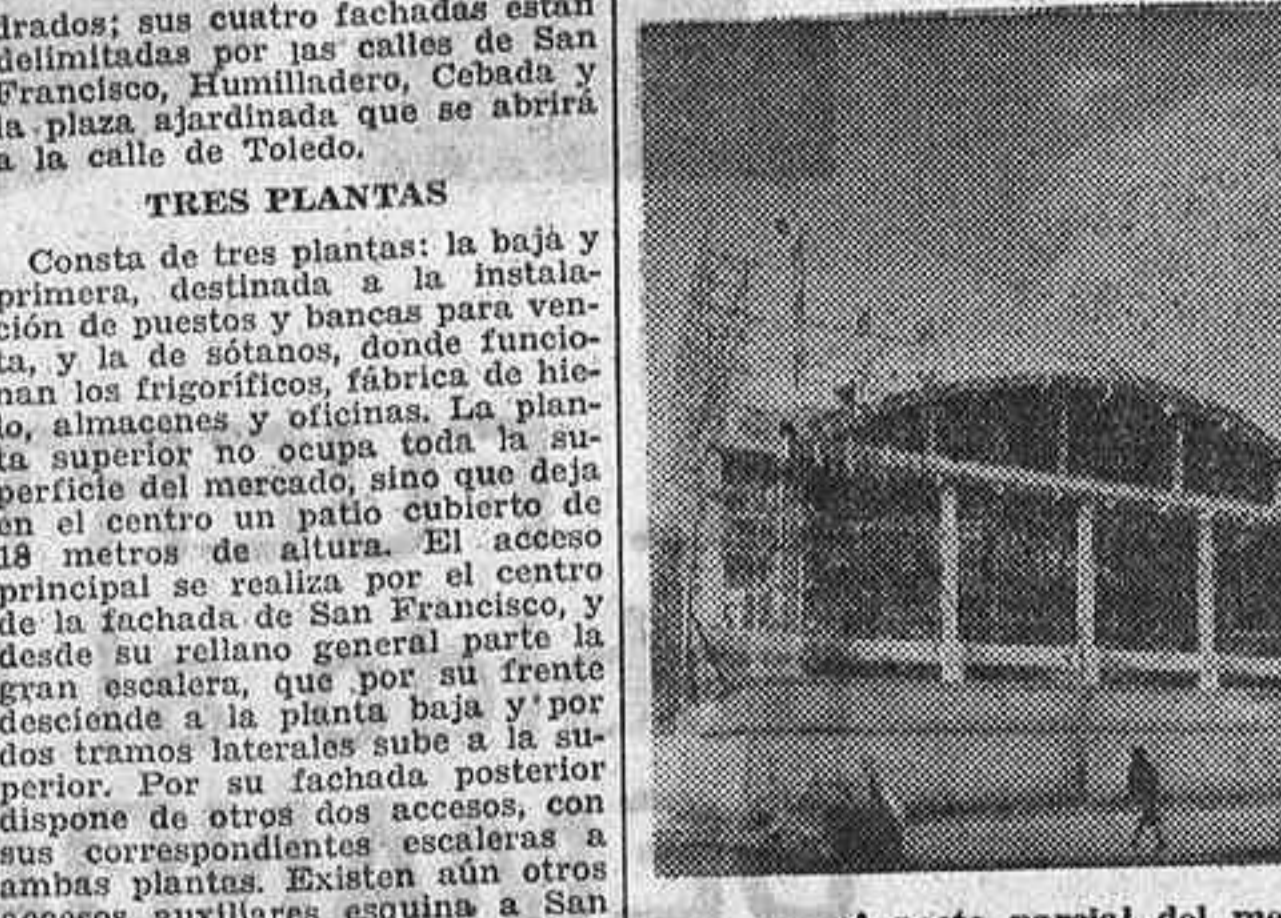
Aspecto parcial del mercado en construcción
