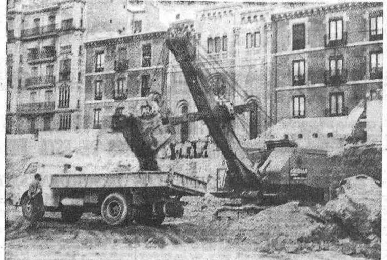
Moderna máquina oruga norteamericana, empleada en las obras que se realizan en el solar del Hospicio para la construcción de un moderno mercado que absorberá los puestos callejeros de la Corredera. Este artefacto realiza en veinte segundos las operaciones de derribo de nuevo toneladas de tierra y carga en camiones. (Foto Portillo.)
