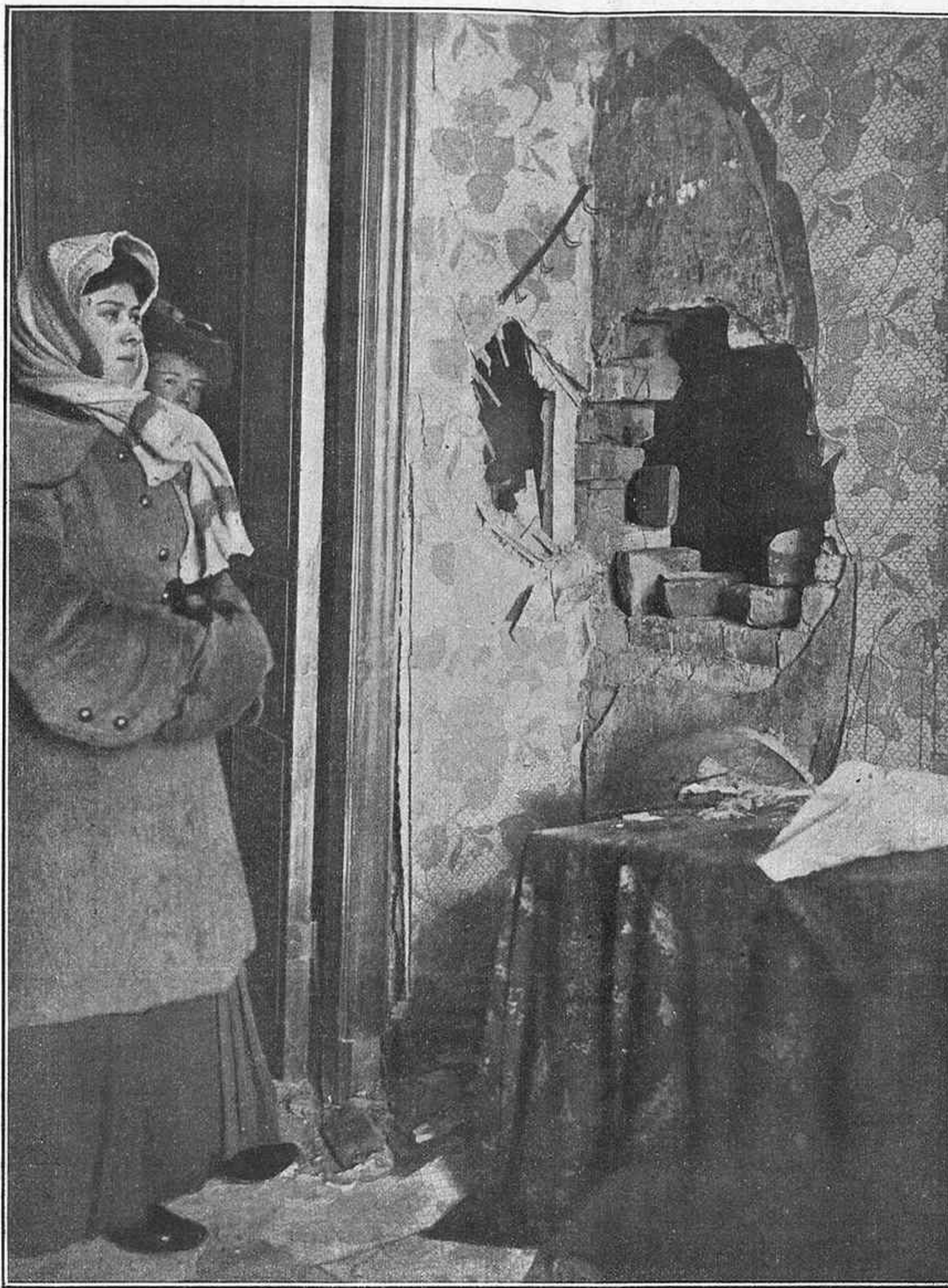
Rusia.—Disturbios revolucionarios en Moscou Efectos de un proyectil de artillería en una casa del arrabal Pressnaya (De fotografía comunicada por «Photo-Nouvelles.»)
