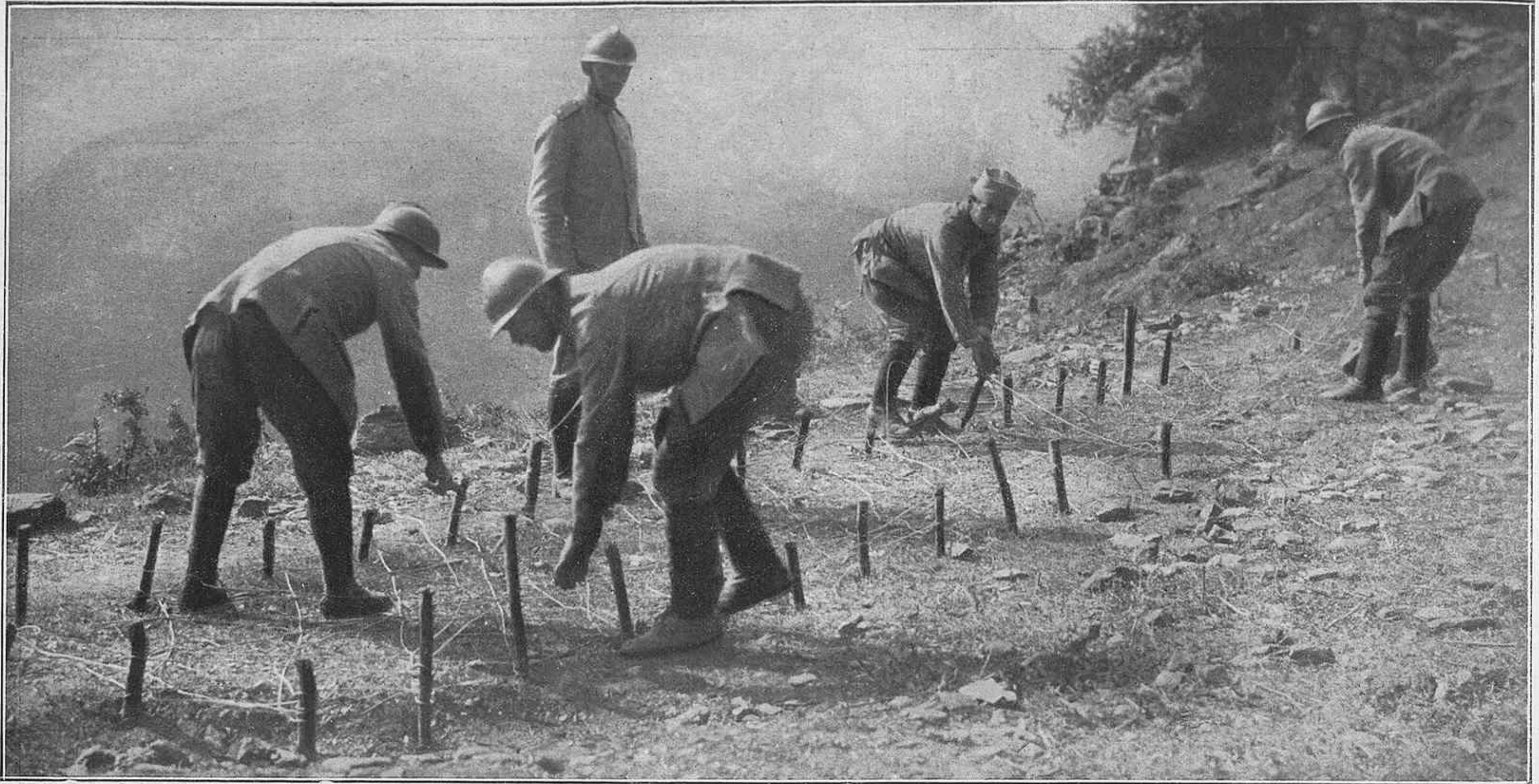
La guerra europea. Los serbios en el frente de Salónica. — Soldados serbios construyendo alambradas en la falda de una cordillera a corta distancia de las posiciones ocupadas por los búlgaros
