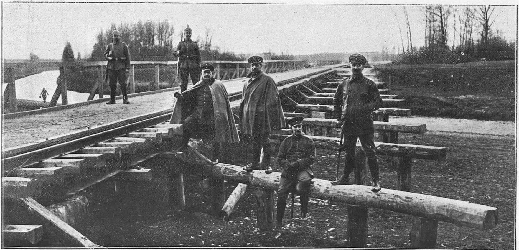
Puente de ferrocarril construído en un solo día por las tropas alemanas. (De fotografías de Hofer.)
