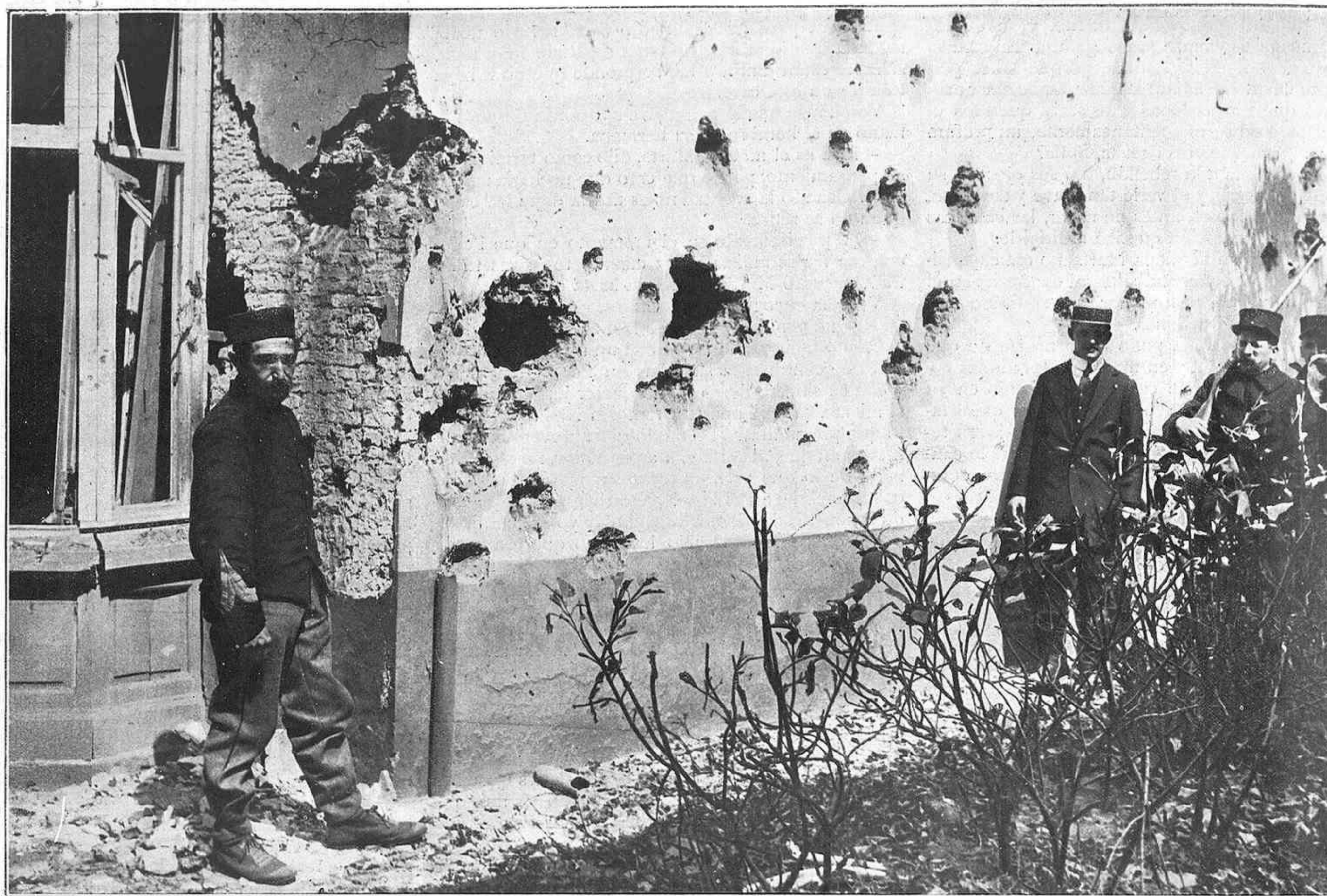
Efectos de una bomba arrojada desde un «Zeppelin»; la pared destrozada distaba diez metros del sitio en donde estalló la bomba
