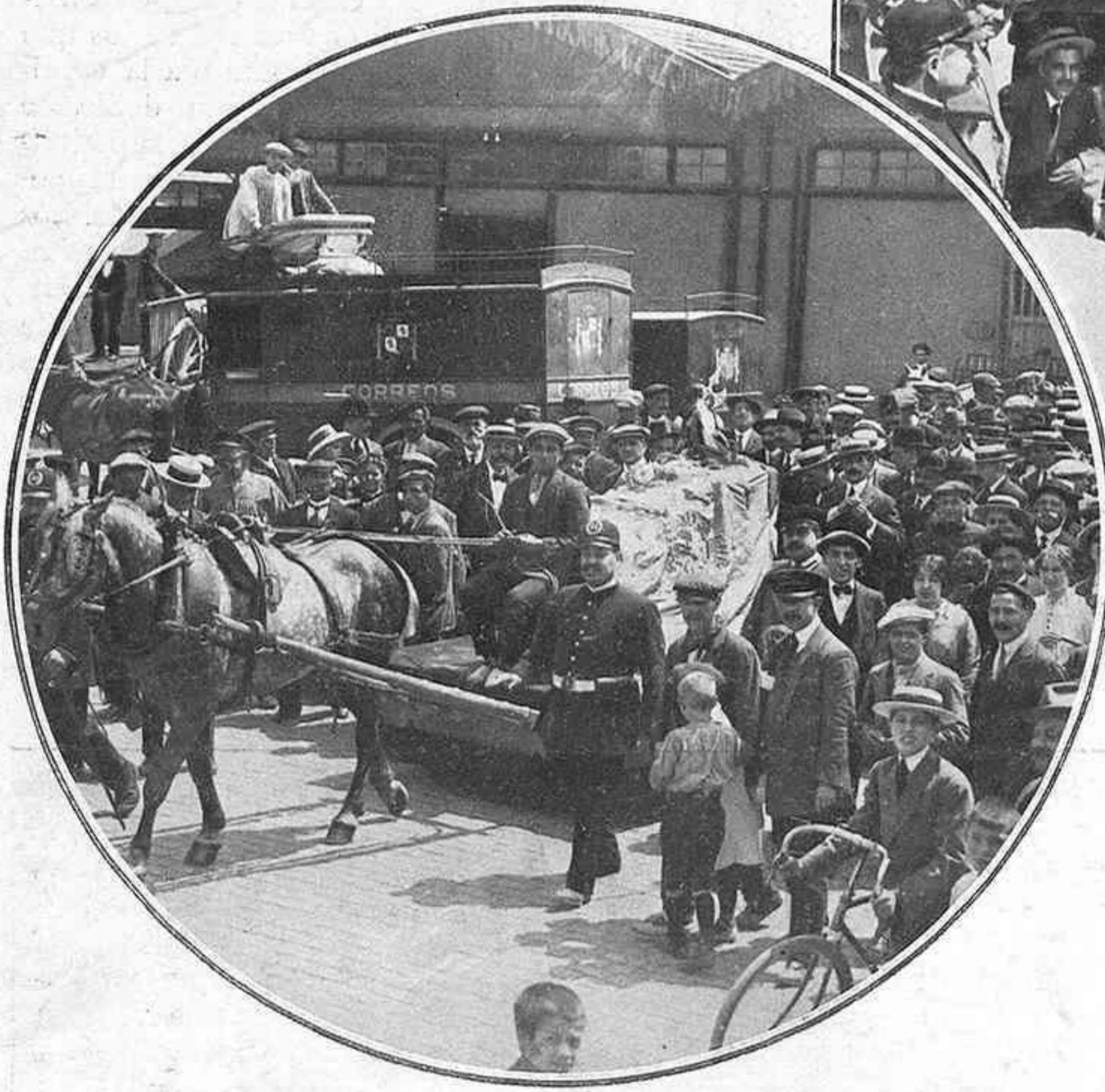
Camión con las piedras históricas de las tres provincias aragonesas sobre las cuales ha de asentarse el edificio social que en breve construirá el Centro Aragonés de esta ciudad.
