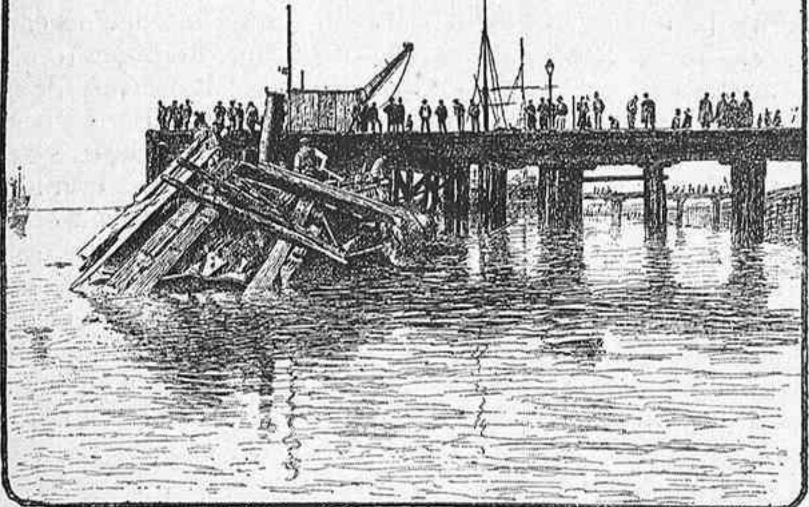
Máquina Perforadora y tablas flotando después de la 2.ª explosión.
