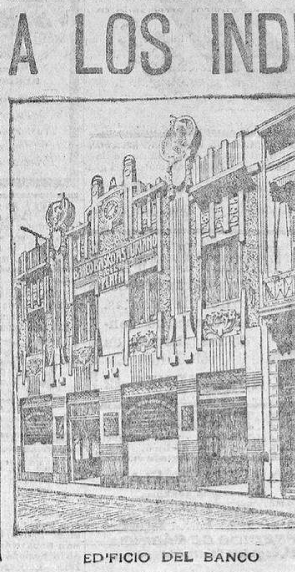
EDIFICIO DEL BANCO
