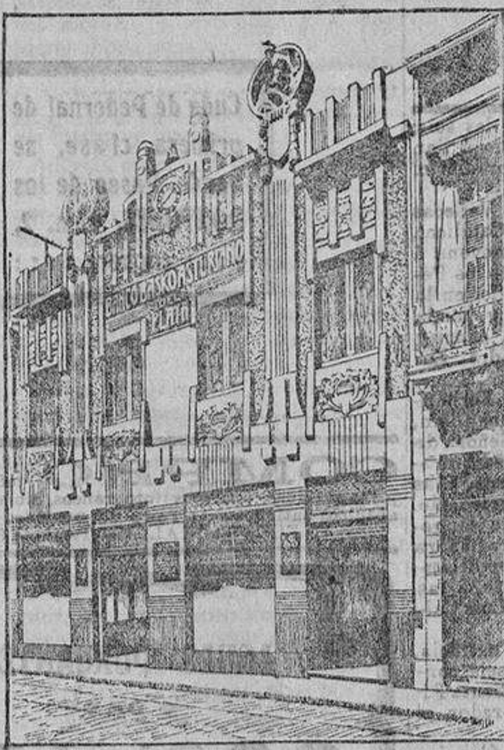
EDIFICIO DEL BANCO
