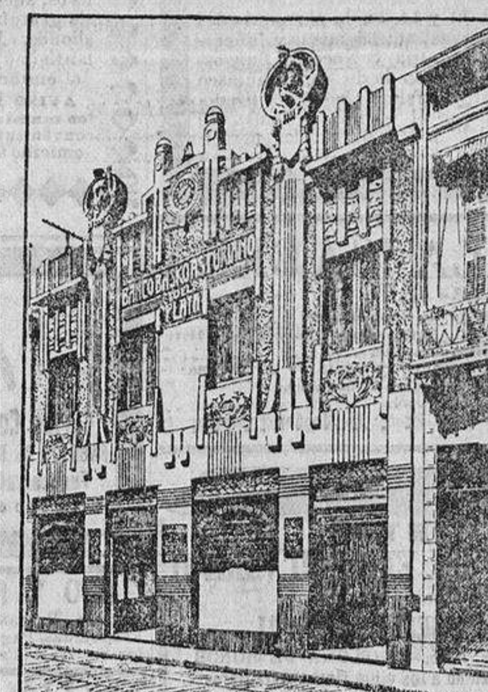
EDIFICIO DEL BANCO
