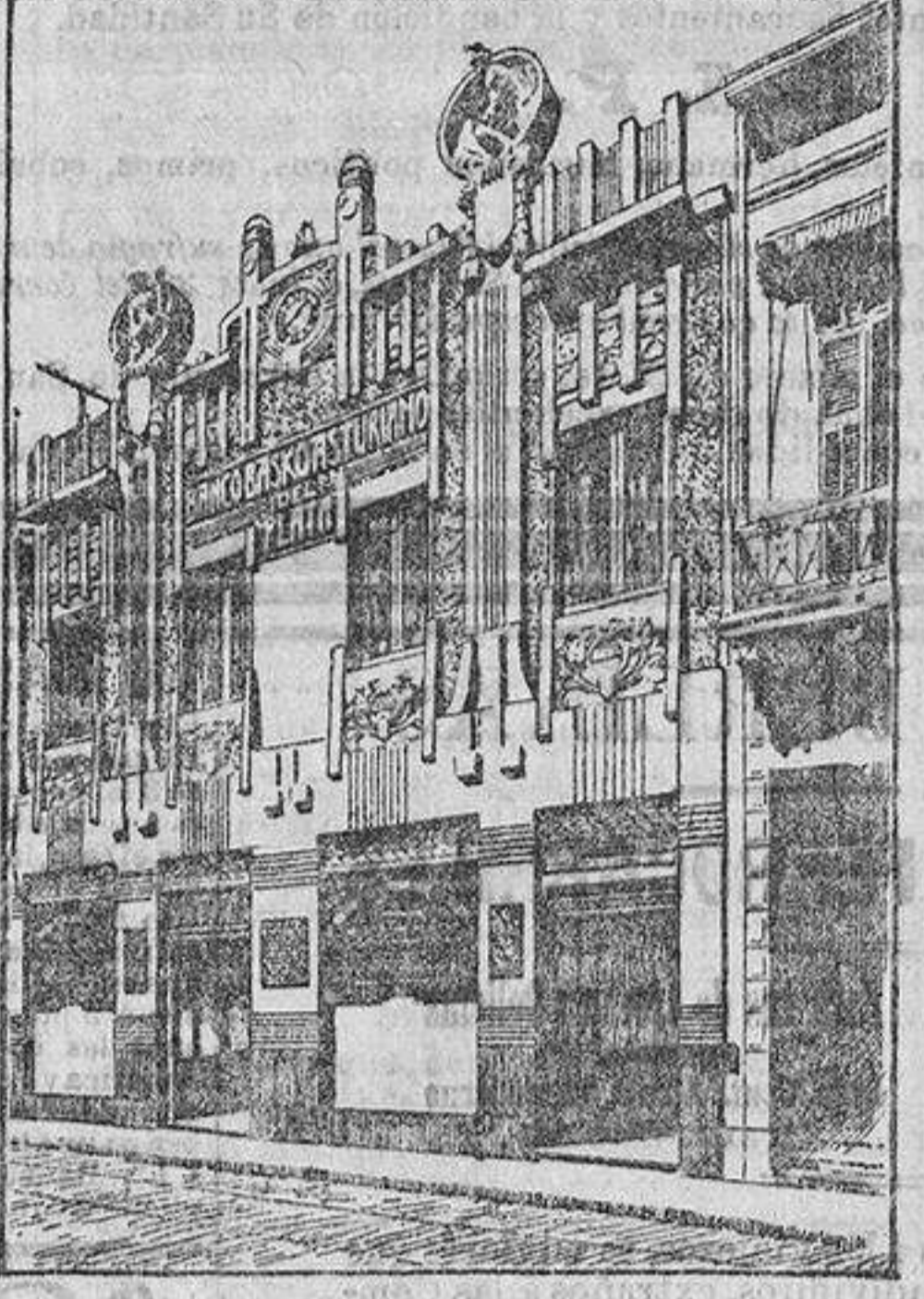
EDIFICIO DEL BANCO
