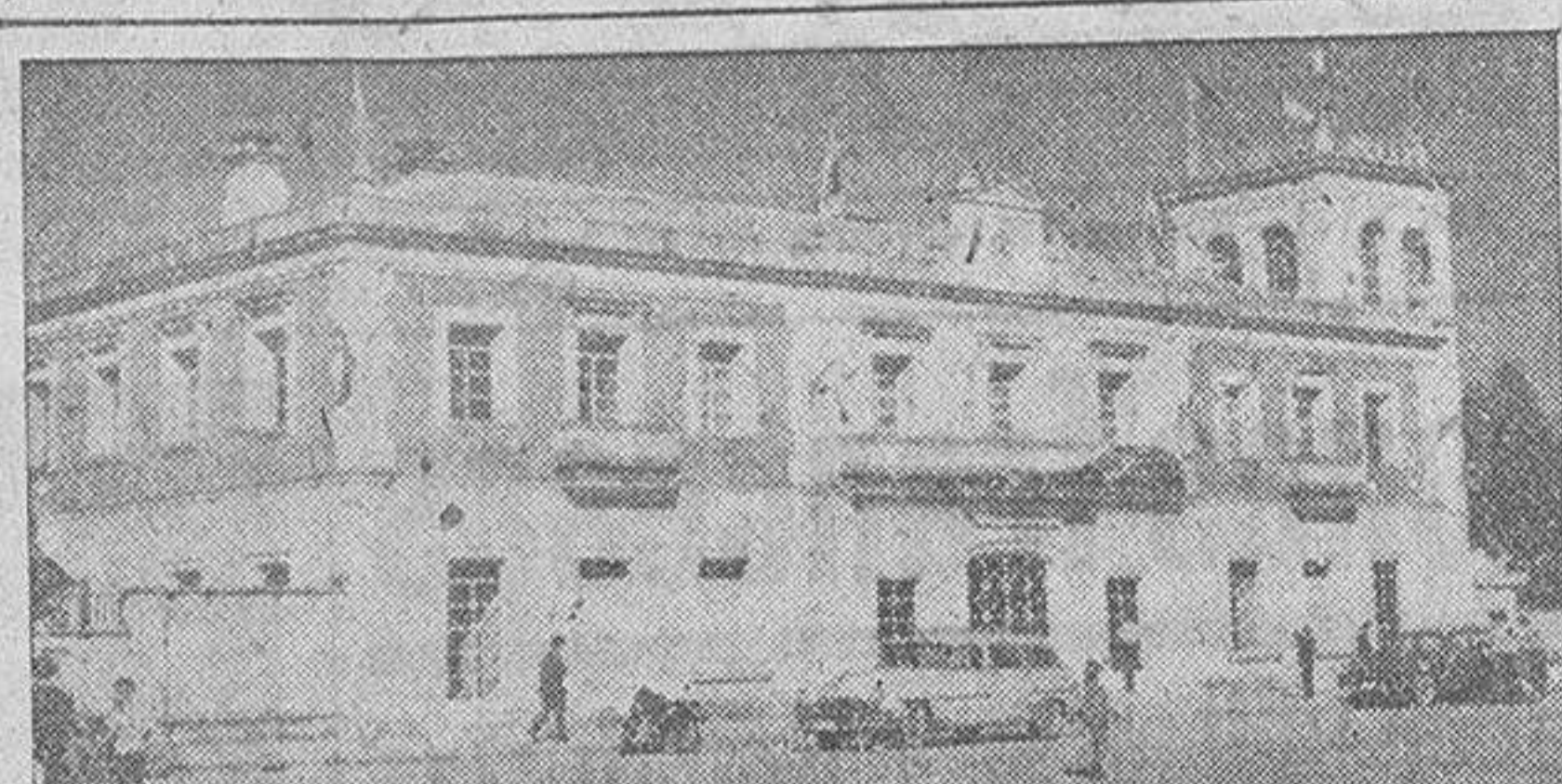
Perspectiva de la moderna estación de Carballino, que recientemente fué inaugurada por S. E. el Jefe del Estado, con motivo de la entrada en explotación del último tramo de la línea férrea La Coruña-Madrid, por Zamora. En los proyectados ferrocarriles de Pontevedra-Carballino y el central de Galicia, la Villa del Arenteiro figura como principal punto de entronque de las comunicaciones ferroviarias de nuestra región. (Foto Blanco).
