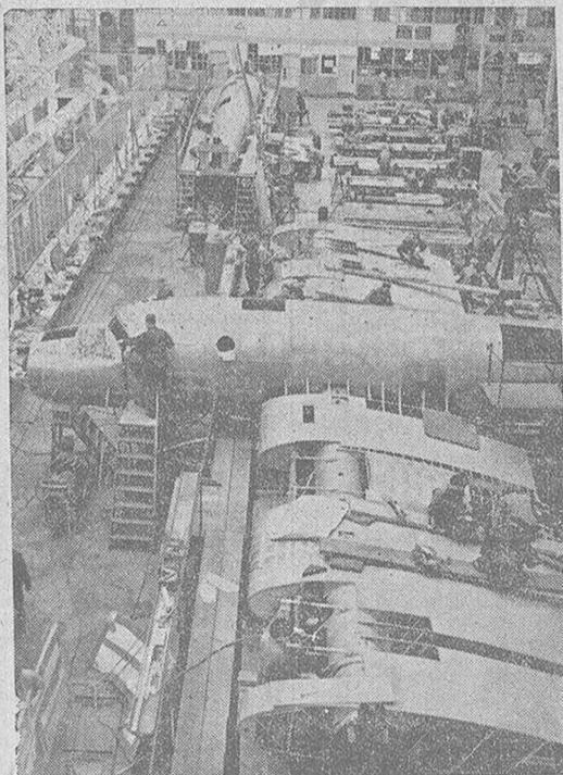
Interior de una fábrica alemana de aviones, donde se fabrican en serie los grandes aparatos de bombardeo
