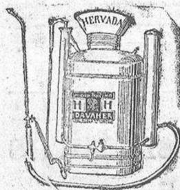
Sulfatador «Racimo» de cobre, válvulas en cámaras exteriores, novedad que facilita el recambio y limpieza por piezas, facil manejo, economía de líquido. Capacidad, 14 litros; pesan unos 5 kilos.
