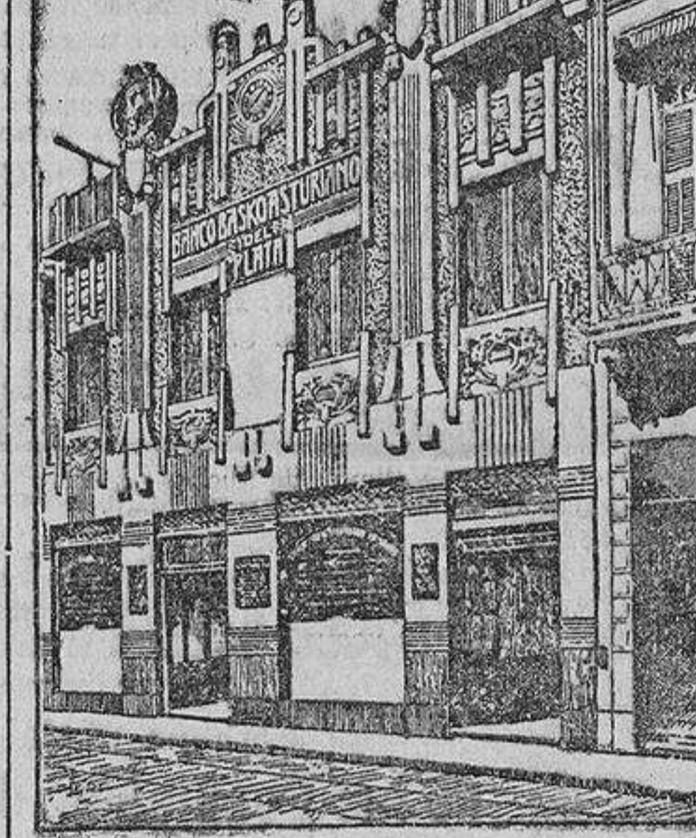
EDIFICIO DEL BANCO
