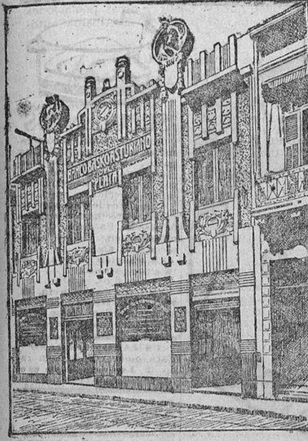
EDIFICIO DEL BANCO
