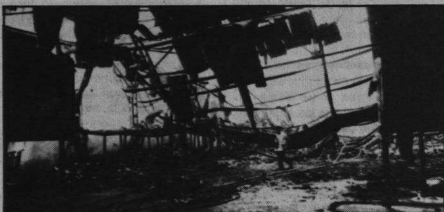
Estado en que ha quedado la fábrica «Aceites Toledo, S.A.» en Yébenes, después del incendio que se registró en la madrugada del domingo, cuyas causas son hasta el momento desconocidas. Las pérdidas materiales se calculan en unos trescientos millones de pesetas
