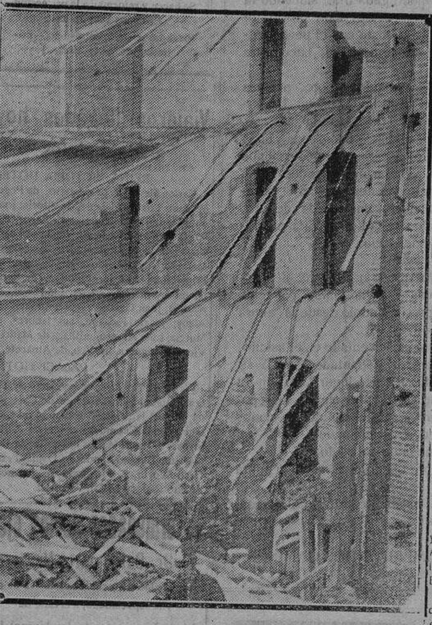
Estado en que se halla la casa en construcción en la calle de Topete que se vino abajo días atrás
