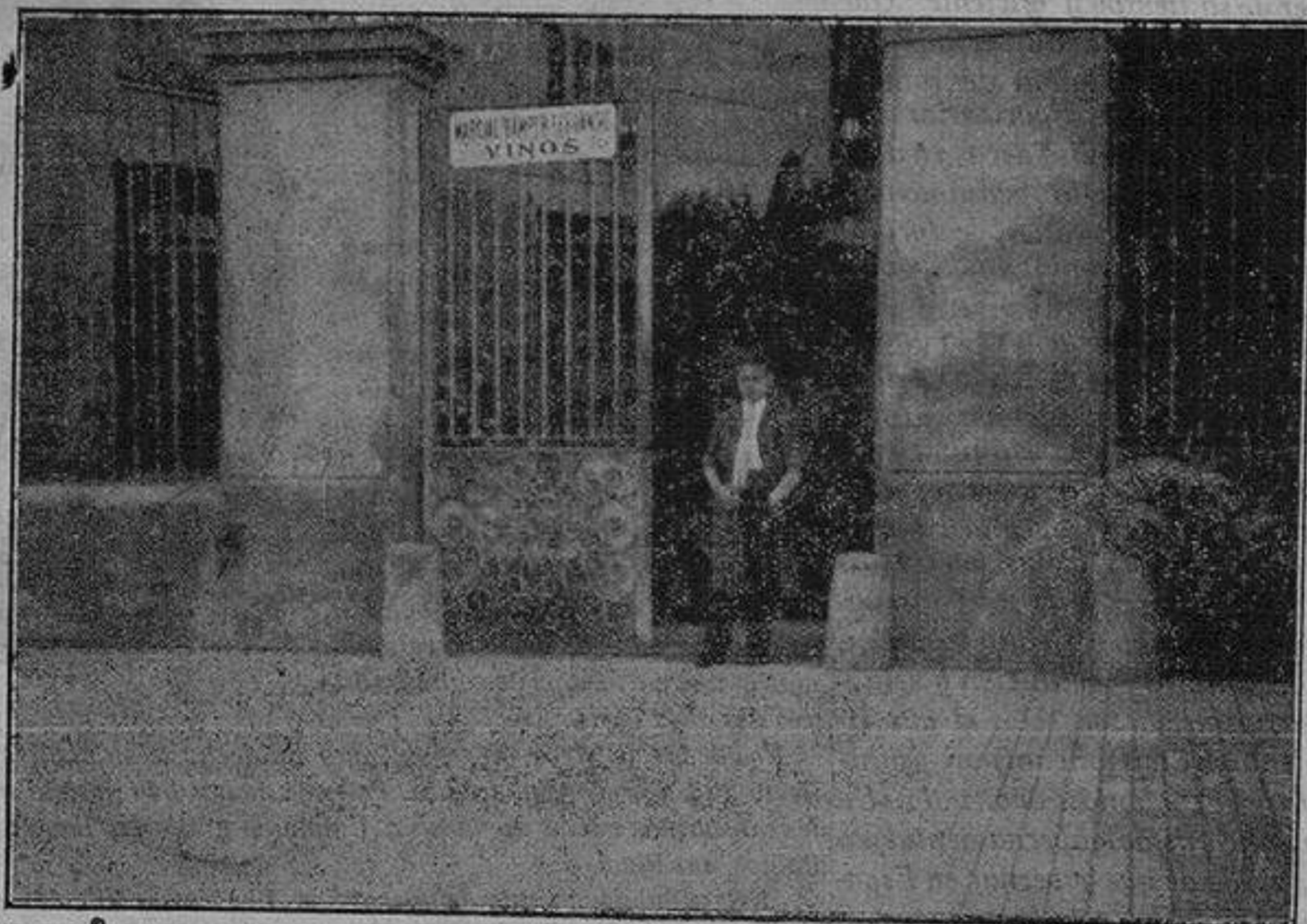
Fachada principal de las oficinas y almacenes
