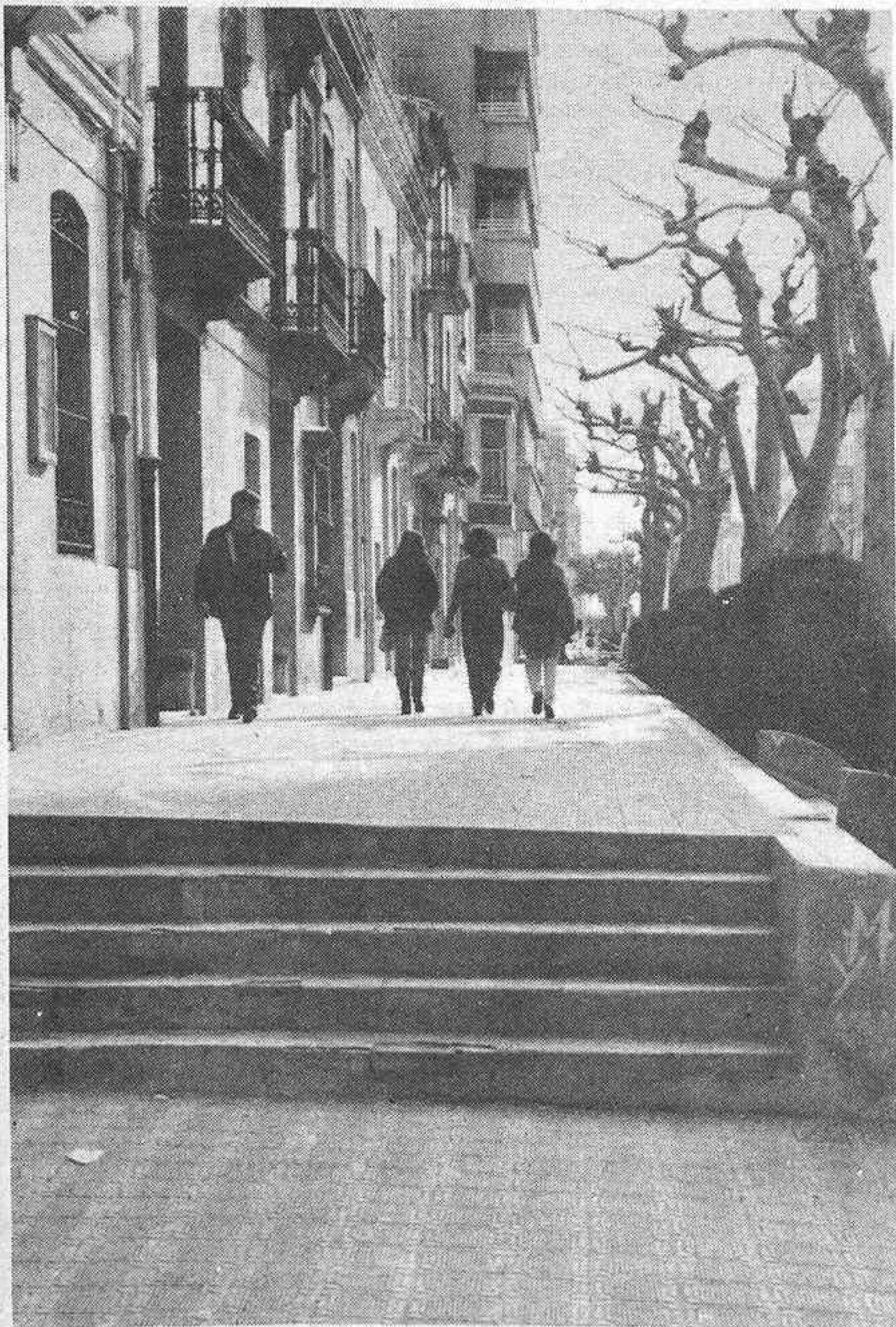
El Ayuntamiento está procediendo a la eliminación de las barreras arquitectónicas que impiden en la acera izquierda de la avenida de la Murá el acceso a personas disminuidas. Las obras que se iniciaron ayer, proseguirán durante las próximas jornadas y han contado con una importante subvención de la administración.
