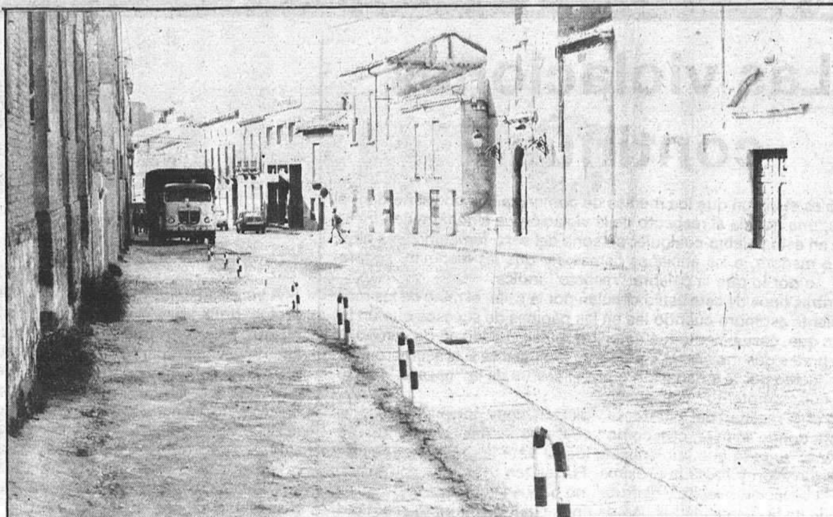
La antigua carretera de Zaragoza será por fin, asfaltada
